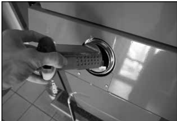
Die Zündkammer in den Kessel einstecken
