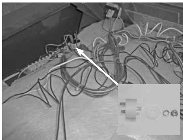
Kondensator für Abzugventilator - 1µF
